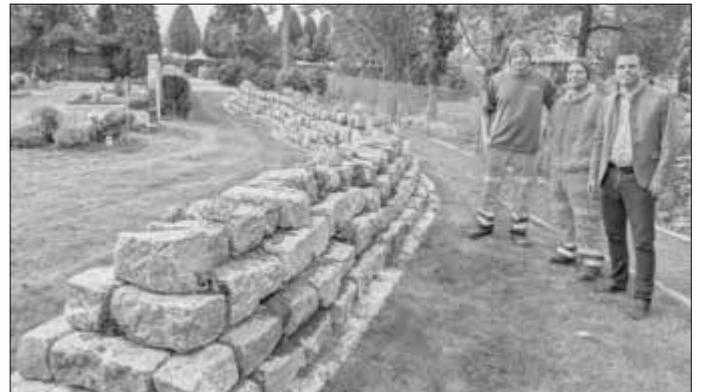
Im nördlichen Bereich des Friedhofes wurde eine weitere Urnenmauer als Trockenmauer aus Muschelkalkquadern errichtet. Die Mauer ist ca. 25 lfdm lang und ca. 1,30 m hoch und hat eine umlaufende Mähkante aus Pflaster, um eine bessere Pflege zu gewährleisten.
